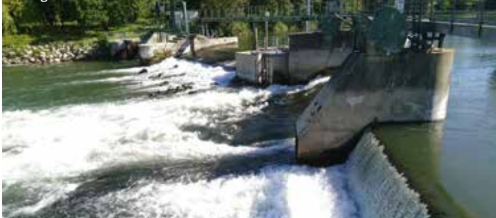
Barrage de Crouin
